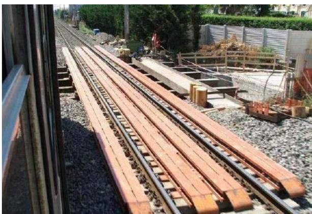
Per quanto concerne invece il sostegno dei binari durante la fase di esecuzione del sottopasso si provvederà mediante realizzazione di un ponte a travi “Essen”. Il sistema Essen, riprendendo i concetti alla base del metodo tradizionale dei fasci di rotaie (fasci di irrigidimento in corrispondenza delle rotaie e travi di manovra), realizza un sistema di vincoli in grado di consentire il transito dei convogli fino a 80 km/h.
